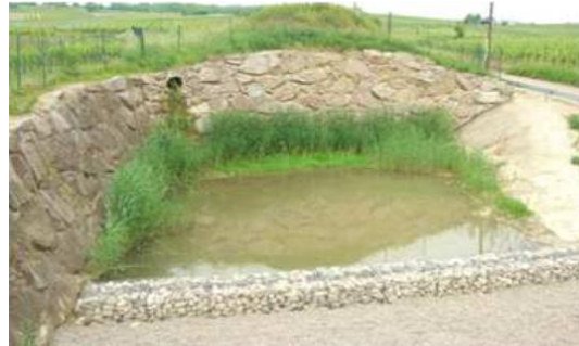
Ouvrage de rétention et remédiation
