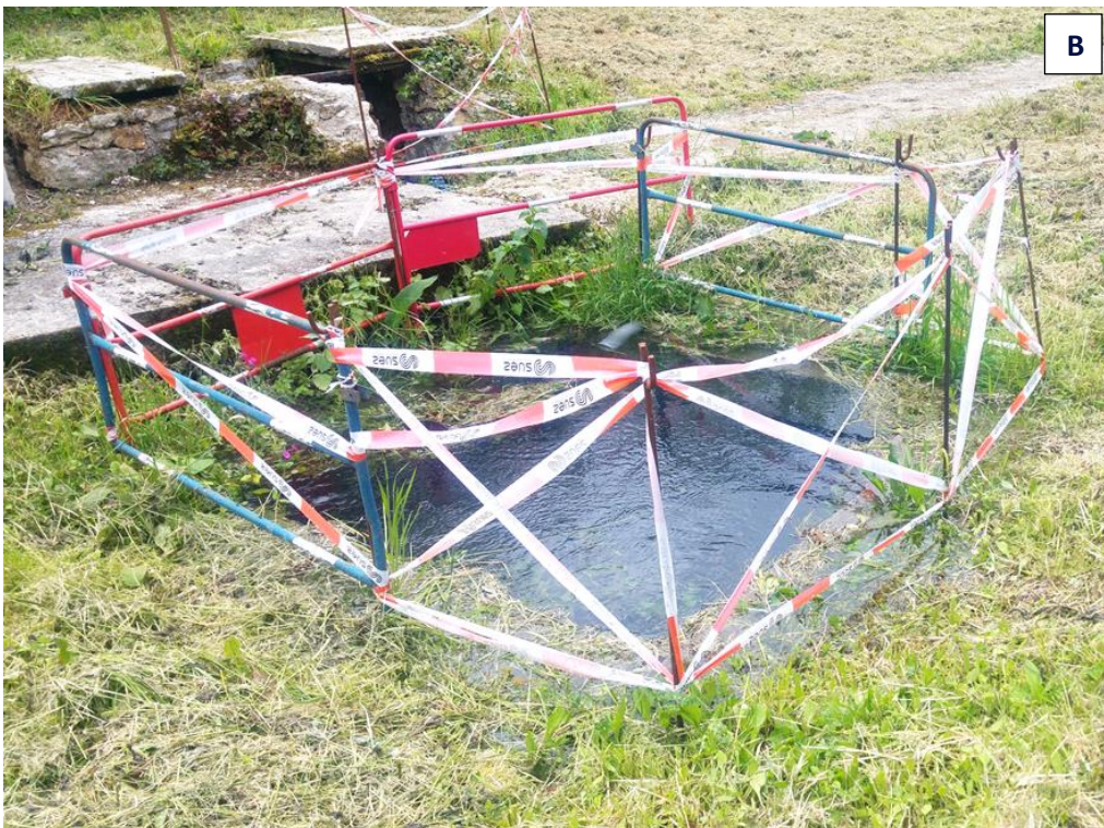
Figure 8 : A : Vue d'ensemble de la parcelle d'exploitation ; B : Ancien bassin de jaugeage utilisé aujourd'hui pour le by-pass ; C : 2 ème chambre de dessablement.
