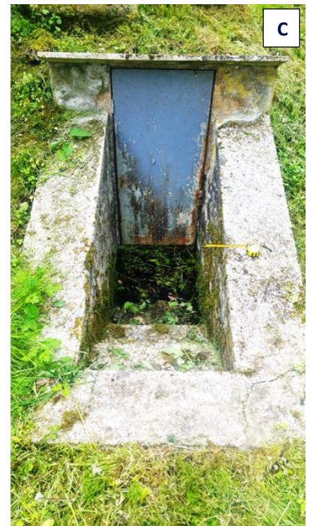
Figure 8 : A : Vue d'ensemble de la parcelle d'exploitation ; B : Ancien bassin de jaugeage utilisé aujourd'hui pour le by-pass ; C : 2 ème chambre de dessablement.
