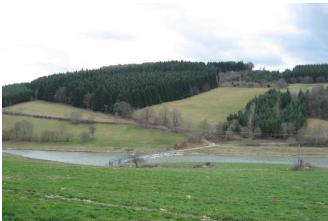
Barrage des Echansieux, SIE du Gantet, Violay - 42
