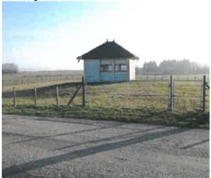
Ouvrage de St Romain
