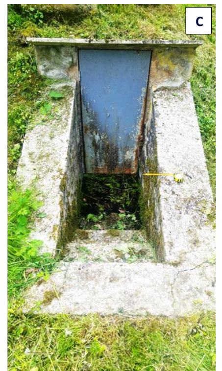
Figure 8 : A : Vue d'ensemble de la parcelle d'exploitation ; B : Bassin de rétention ; C : 2 ème chambre de dessablement.
