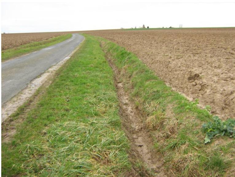
Figure 4-1 : Photo d'un fossé enherbé de collecte des eaux pluviales (Source SAFEGE, 2014)
