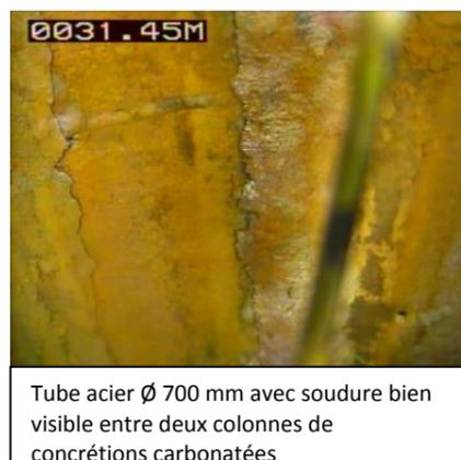
Tube acier Ø 700 mm avec soudure bien visible entre deux colonnes de concrétions carbonatées
