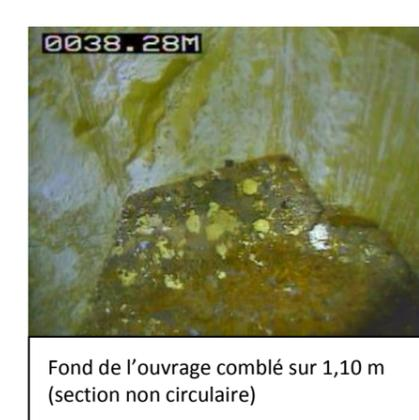
Fond de l'ouvrage comblé sur 1,10 m (section non circulaire)
