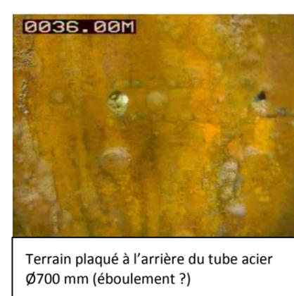
Terrain plaqué à l'arrière du tube acier Ø700 mm (éboulement ?)
