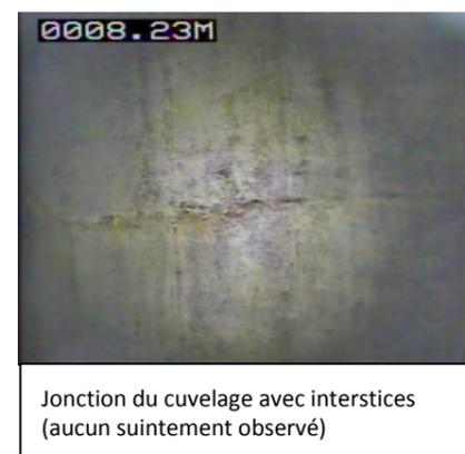
Jonction du cuvelage avec interstices (aucun suintement observé)
