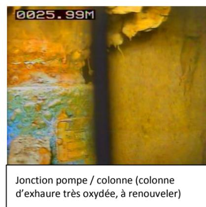
Jonction pompe / colonne (colonne d'exhaure très oxydée, à renouveler)
